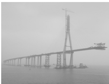
우리를 반겨준 건설 중인 제2 영종대교
